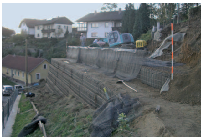
Momentaufnahme während der Bauphase
