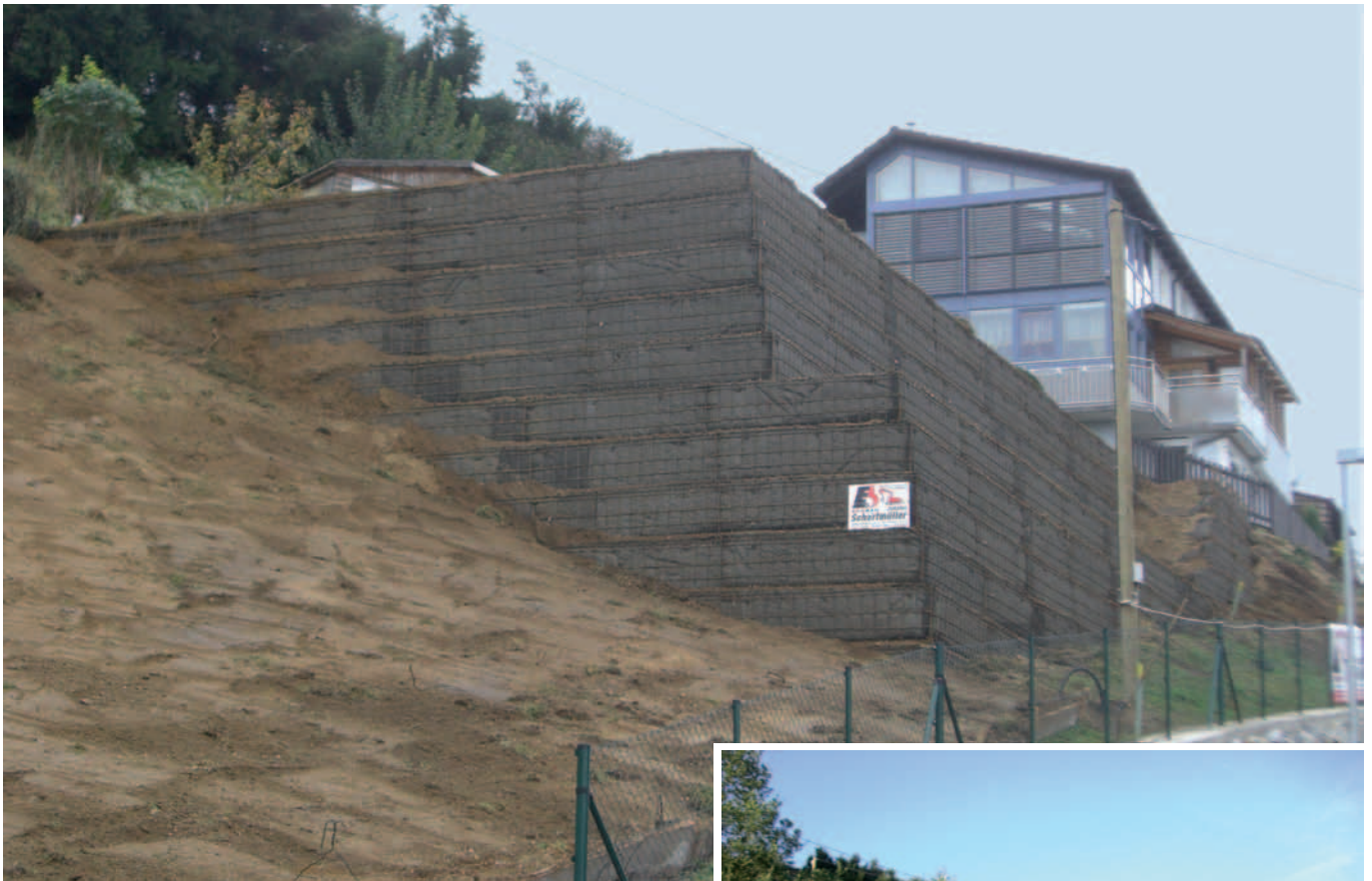
Das fertige Bauwerk
