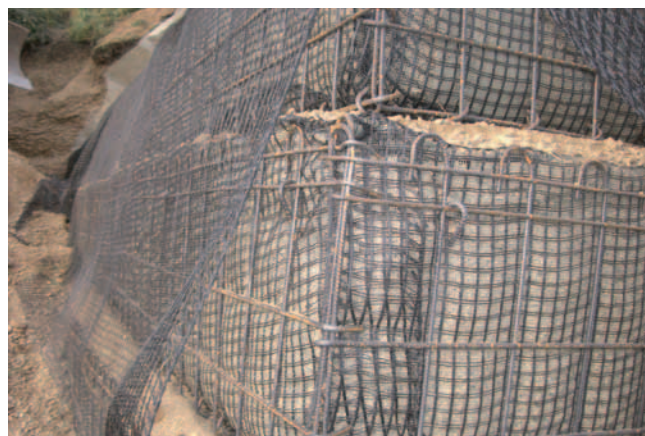
Aufbaudetail im Eckbereich des Grundstückes
